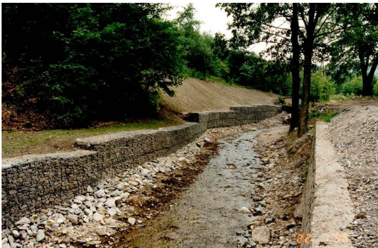
Fot.2. Ściana oporowa z gabionów 2x1x1m ładnie wkomponowuje się w środowisko
