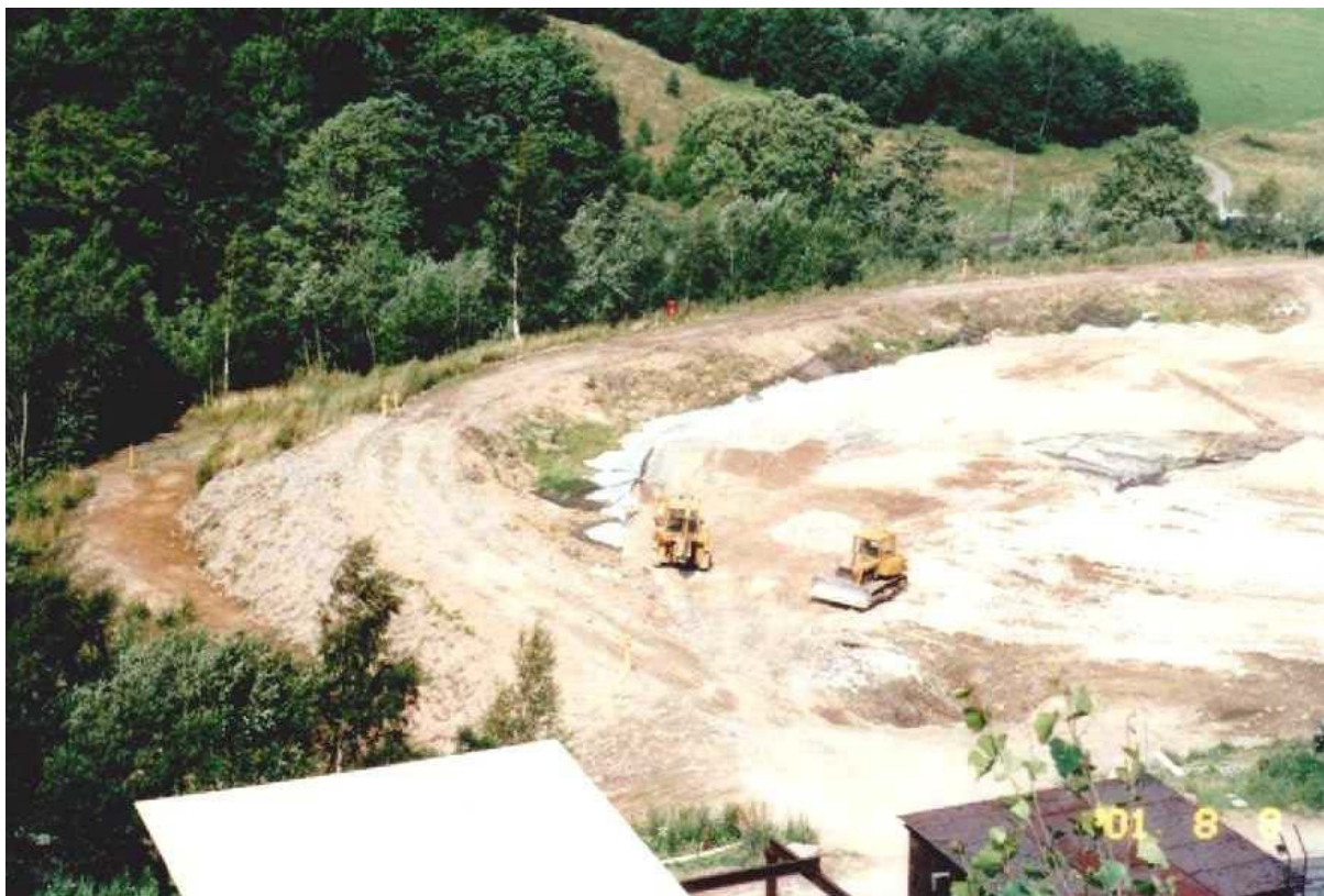
Fot.3. Roboty ziemne. Rozścielanie dolomitu na geowłókninie i geosiatce
